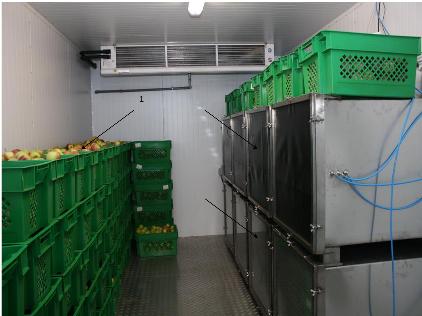
Варианты хранения в одной из холодильных камер в Мичуринском ГАУ 1 – обычная атмосфера; 2 – ULO; 3 – DCA.
